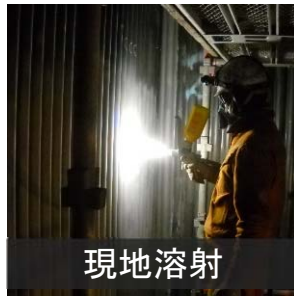
ガイドライナー耐摩耗溶射
